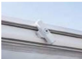
Il dispositivo di bloccaggio del profilato a incastro deve essere ruotato solo di un quarto di giro.
